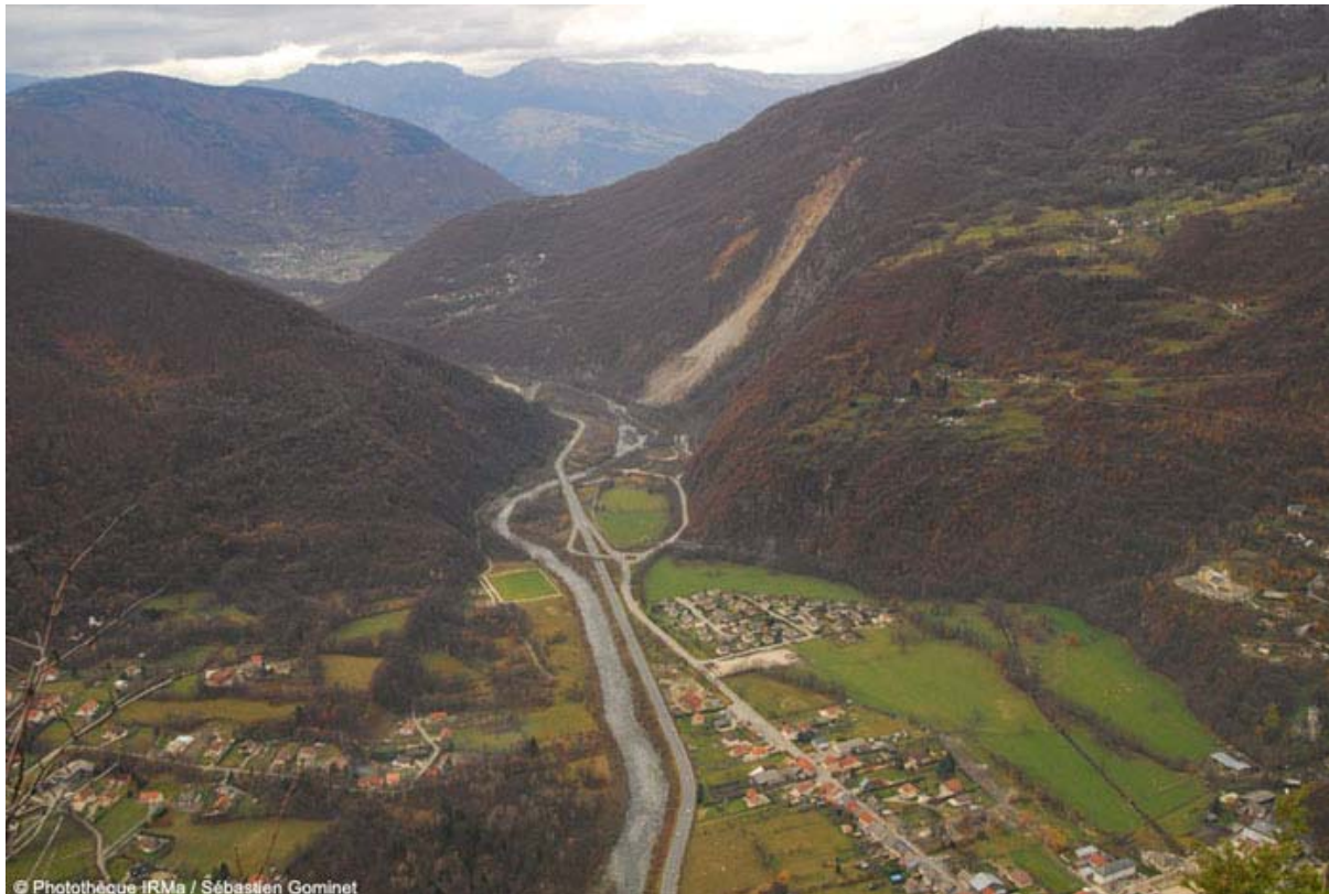
Glissement de Séchillienne (Isère)
