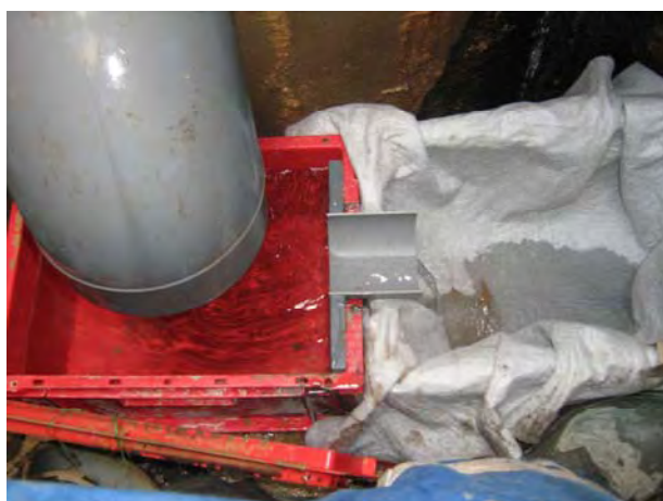
Figure II.4 : Photographie du système de récupération du sol transporté après réparation
