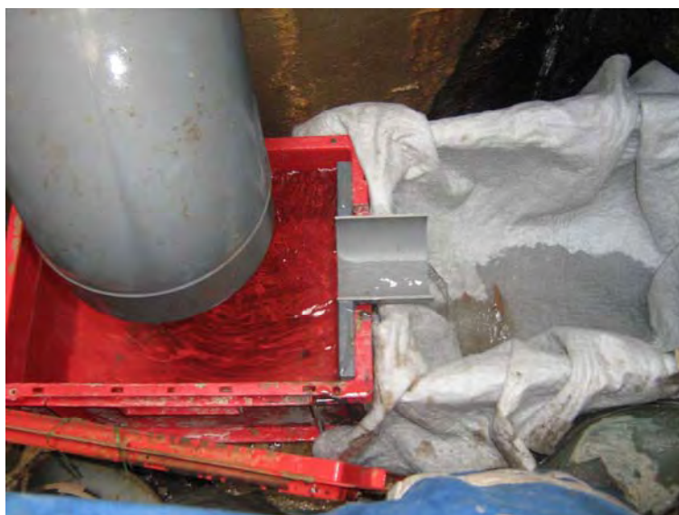
Figure I.20 : Photographie du dispositif de récupération du sol transporté
