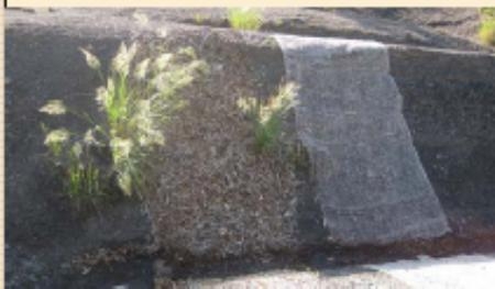
Installation de 5 cm d'épaisseur de BRF directement sur le substrat. Tenue observée sur fortes pentes (jusqu'à 100 %)
