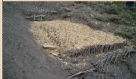
Installation de 5 cm d'épaisseur de BRF sur des ouvrages de génie biologique, sur matériaux meubles. En cas de ruissellements concentrés, ne pas installer sans ouvrage.
