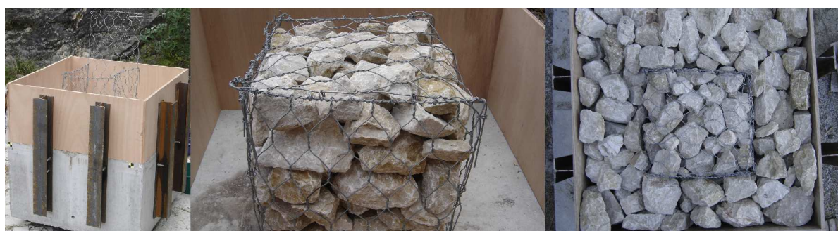
Figure 5 : mise en œuvre du confinement matériau CM pour une cellule 500 granulat : cage avant remplissage, cage remplie et cage confinée matériau (vue de dessus).
