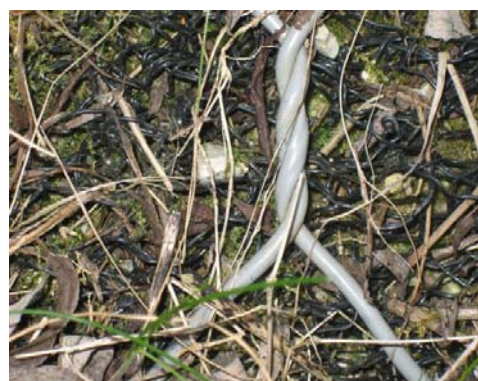
Détail du grillage et de la géogrille
