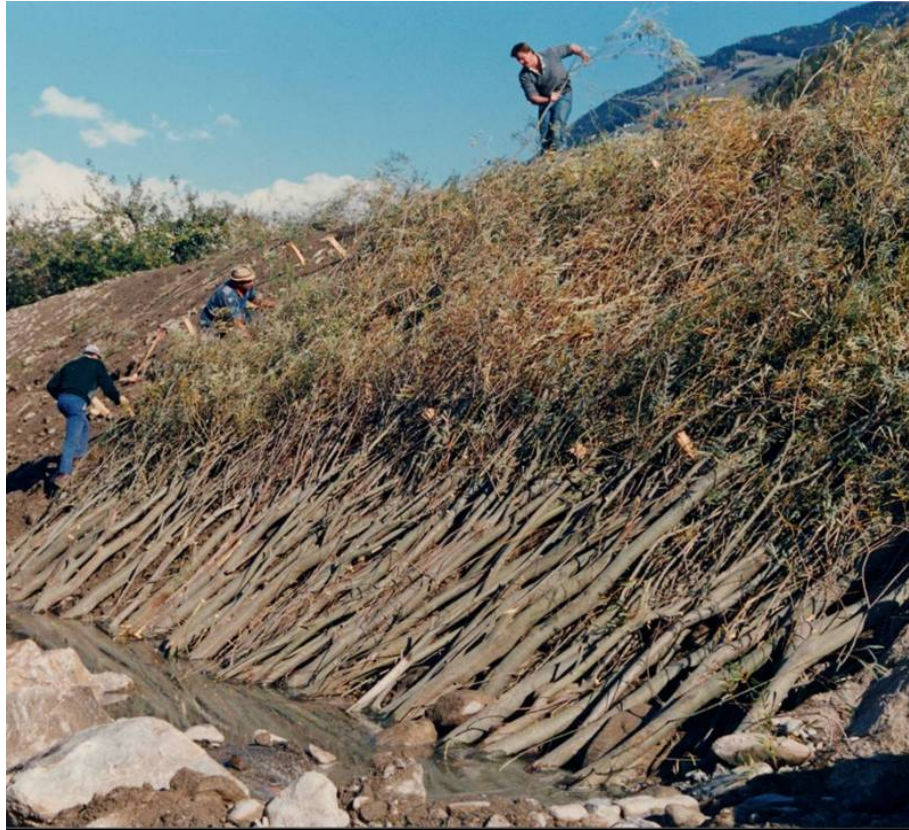
Photo : Réalisation au Sud Tyrol 1992 - Department of hydraulic engineering - Autonomous Provinz of Bozen/Bolzano - South Tyrol / Italy
