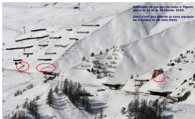
Fig. 28. Ouvrages de protection contre les avalanches (Tignes)
