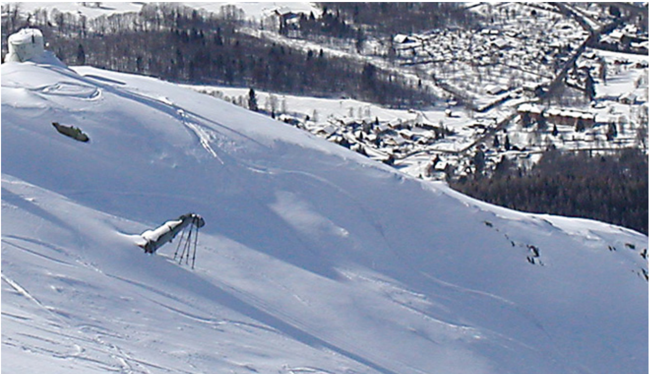
Figure 3 : L'un des 5 explodeurs Gazex permettant le déclenchement des avalanches à distance (photo R. Bolognesi).
