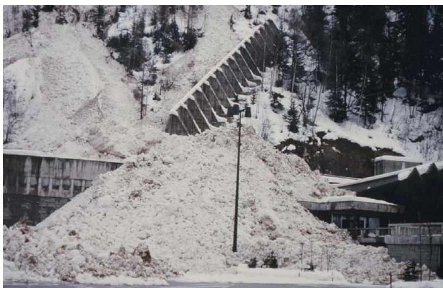
Figure 1 : Avalanche ayant touché les bâtiment et le parking du Tunnel du Mont-Blanc. Le mur de déviation a été prolongé suite à cet accident, mais il ne peut protéger le parking d'une grande coulée de neige (photo A. Salvetti).
