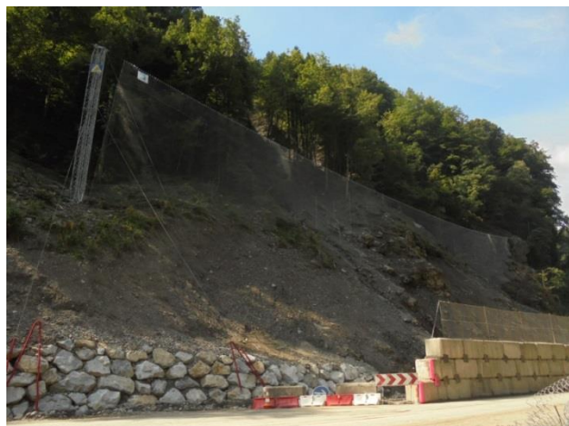
Filet « avaloir » protégeant le personnel lors de la vidange du piège à matériaux
