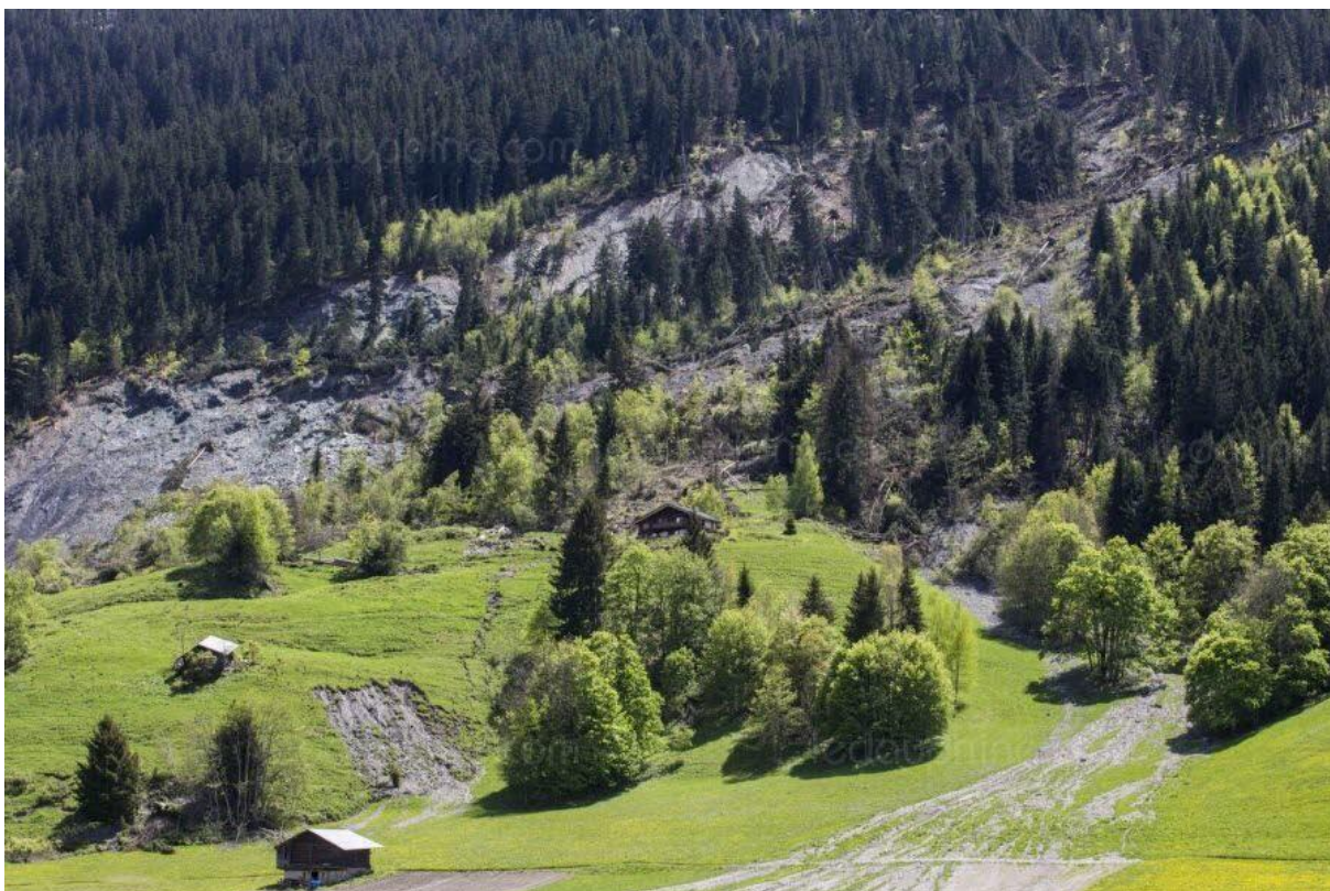
Figure 18 : Glissement du Bersend à Beaufort-sur-Doron (en haut : © IRMa Grenoble ; en bas : © Le DL).
