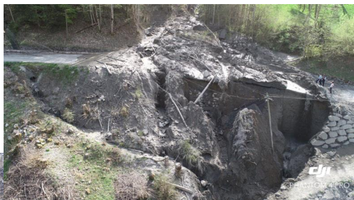
Route partiellement détruite par les laves torrentielles de 2018
