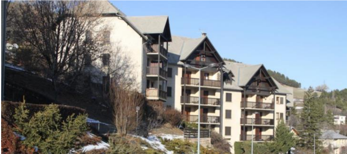
Figure 21 : Habitations affectées par le glissement dans le quartier de la Belotte (©ville-embrun.fr).
