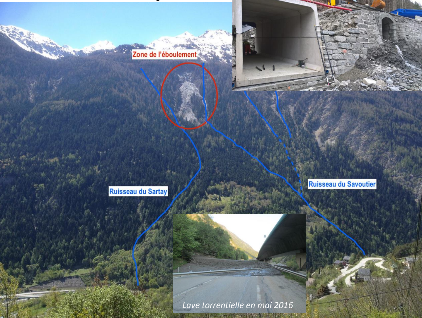
Nouvel ouvrage sous la RD1006
