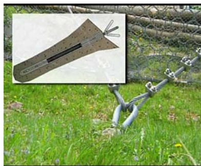
Forces divergentes de l'axe du forage
