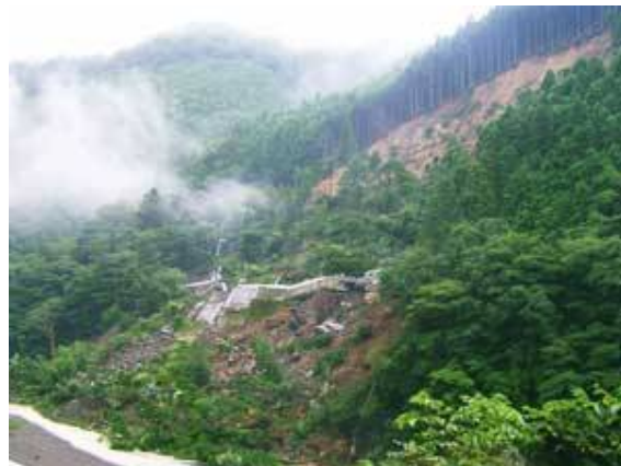
Glissement de terrain à Village Daitô (10/08/2004)
