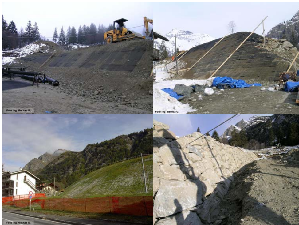
(1) Phases de réalisation des levées de terre renforcées dans la partie frontale de la plage de dépôt
