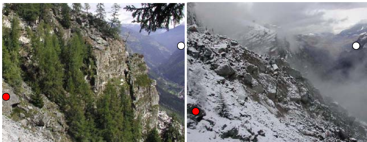
Tête instable avant et après l'écoulement du 21/11/2002, vue de profil
