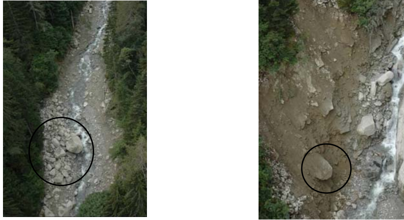
Secteurs successifs de dépôt et d'érosion du lit du torrent
