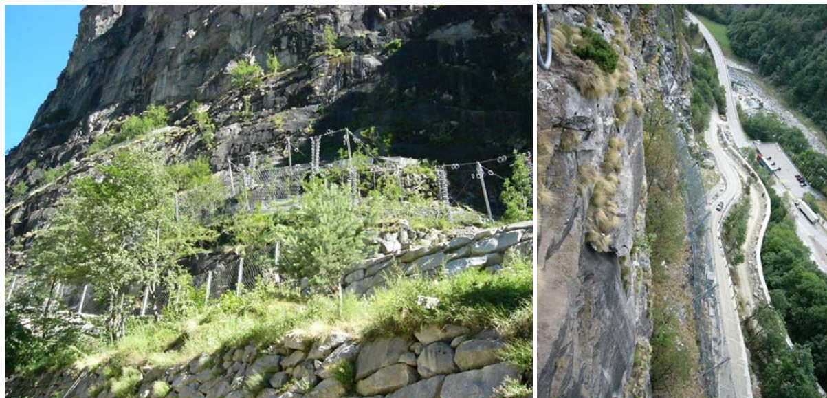
vue des écrans supérieurs depuis le piège à blocs positionné immédiatement au dessus de Gondo
