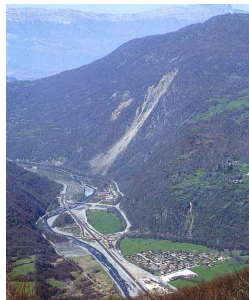
Vue depuis l'amont
