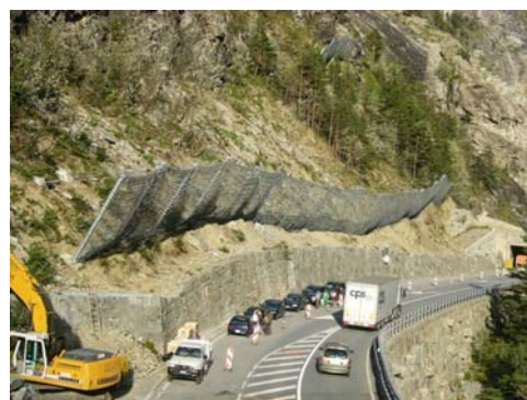
Filets Geobrugg posés au bas de la falaise d'Alphen
