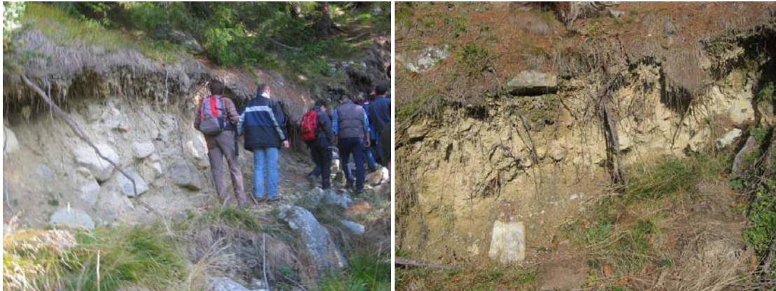
Niche d'arrachement formée en 2003 sur le versant de rive droite
