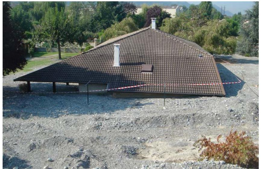
19- Des traces de ruissellement sont visibles le long du mur. La hauteur de crue est d'environ 10 cm par rapport au sol. Le chemin de terre montre des surcreusements réguliers. Ensuite, la topographie s'élève et il n'y a plus de traces d'inondation.
