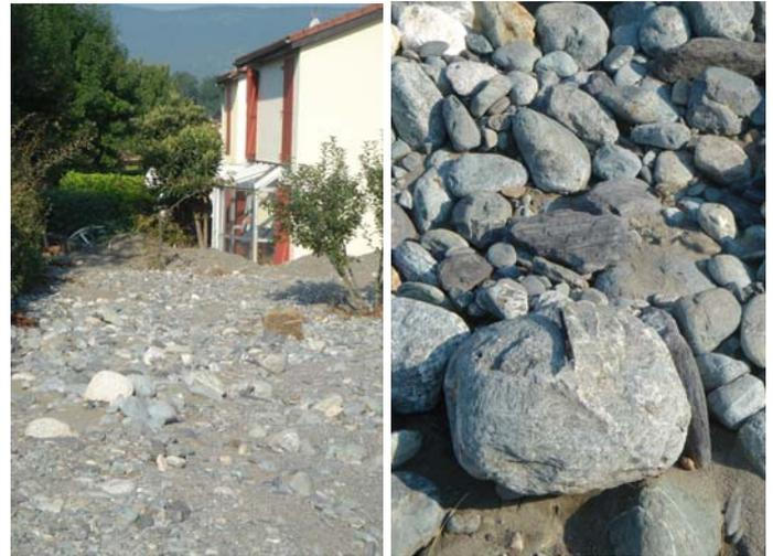
16- La maison est entièrement sous les gravats. Ceux-ci sont constitués de bois, blocs, et de fines. La répartition est très hétérogène. Il s'agit de la maison située immédiatement en contre bas du point de rupture de la digue. Des anciennes traces d'écoulement sont encore visibles. La partie gauche du jardin n'a été affectée que par des dépôts d'argile.
