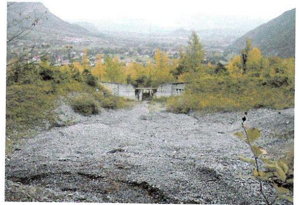
Figure 56 - La plage de dépôt du torrent de la Lampe
