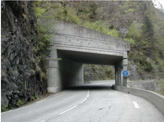
Fig. 1 : Galerie de protection routière conventionnelle
