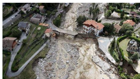
Dégâts occasionnés par la tempête Alex
