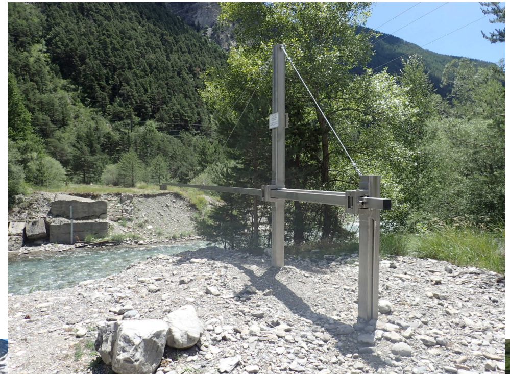
Capteur de niveau sur portique – Ubaye – Contamines (04)
