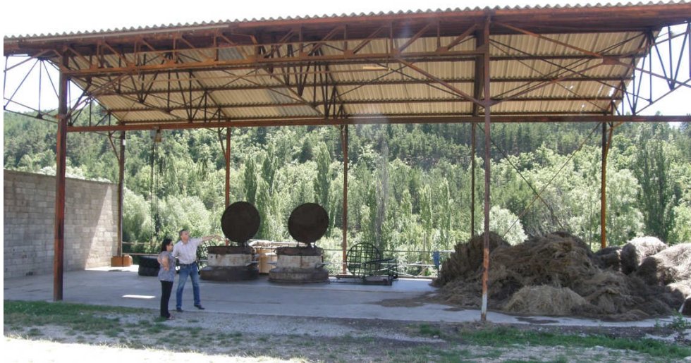
Distillerie de lavande - Mévouillon
