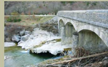
Embâcles sous une des arches constitués par des végétaux de grandes tailles et affouillement du seuil au pont de Cornillon. (Source photographique : SIDRESO)
