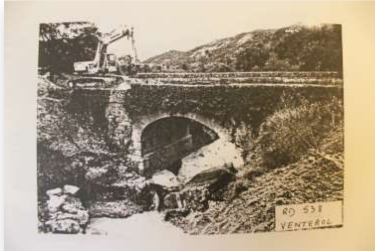
Photo 11 : Pont situé sur la RD 538 détruit au cours des inondations de 1992 (Archives du Service Technique Départemental de Nyons).
