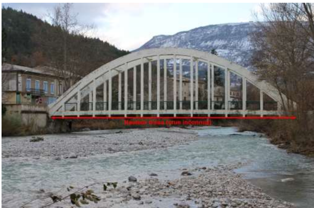
Photo 2 : Le pont de Rémuzat sur l'Oule – Repère de la crue du 13 août 1868
