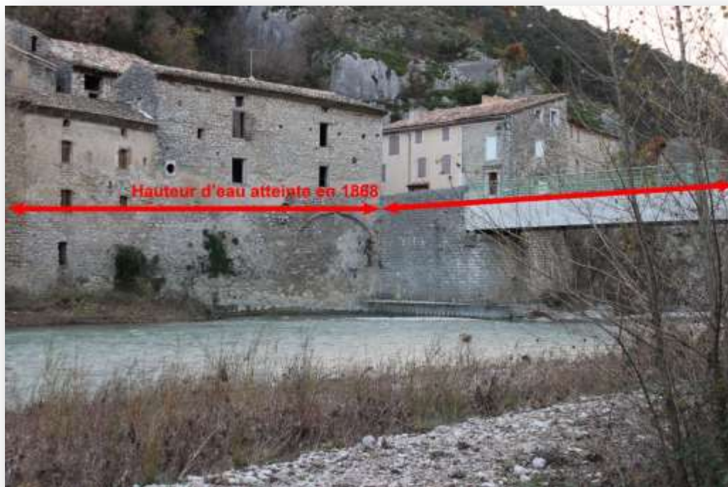
Photo 6 : Amont du pont des Pilles
