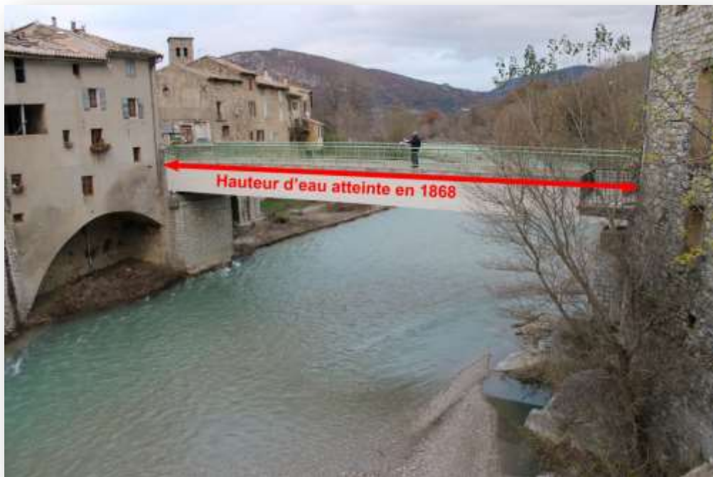
Photo 5 : Aval du pont des Pilles
