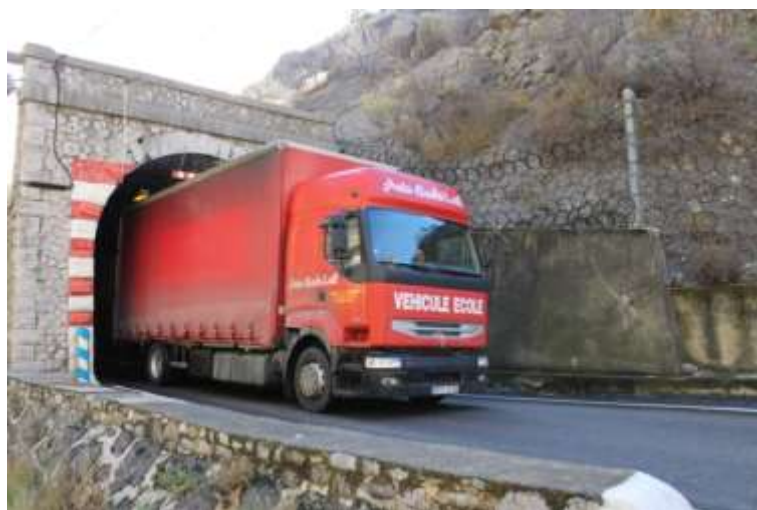
Photo 8 : Filet de protection à l'entrée du tunnel du Trou du bœuf
