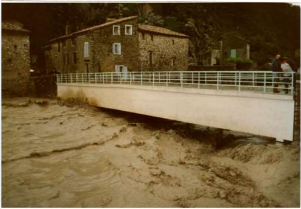
Photo 4 : Crue de l'Eygues du 22 septembre 1992 à l'aval du pont des Pilles (Don du Maire des Pilles aux étudiants de M2GcRN)
