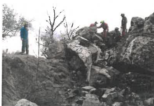
Purge de blocs
