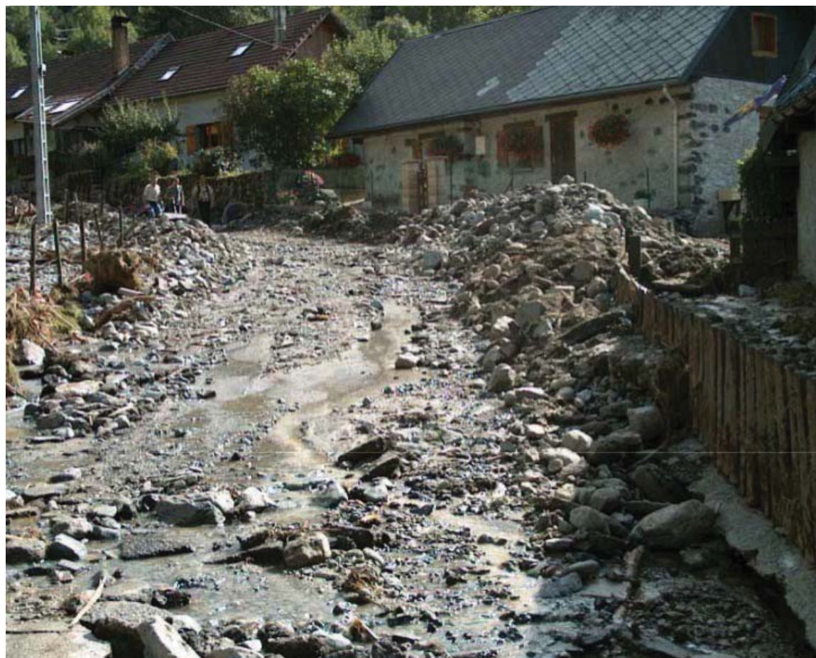
Crue du Vorz à Saint Agnès en Aout 2005.
