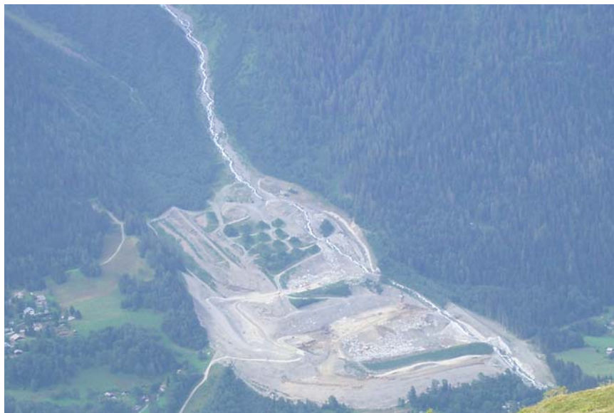
Figure 11 : Couloir de Taconnaz et travaux de construction du nouveau dispositif – Août 2010 (R. Burnet)
