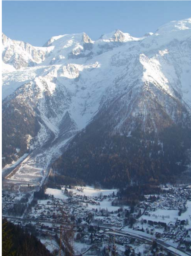
Figure 10 : Couloir de Taconnaz et dispositif de protection conçu en 1999
