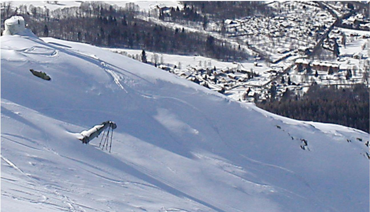
*Figure 3 : L'un des 5 explosifs Gazex permettant le déclenchement des avalanches à distance (photo R. Bolognesi).*
