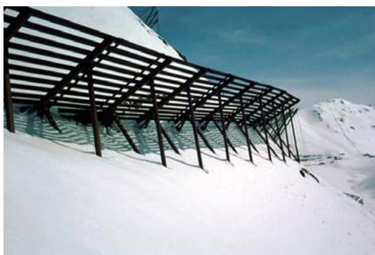
Figure 11 : Snow bridge type Zölling-SA
