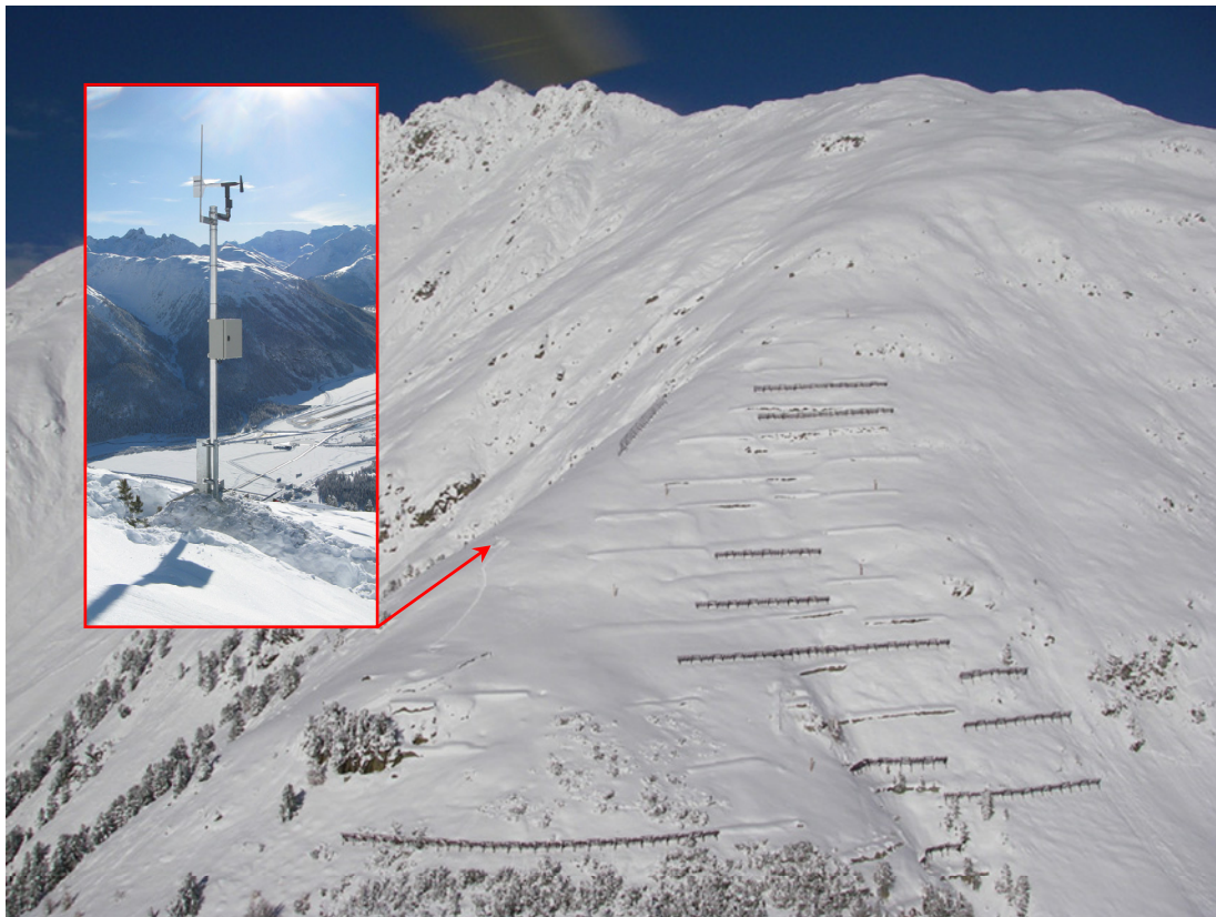
Figure 5 : Station de mesure automatique du vent près des paravalanches de Crasta Mora au-dessus du village de Bever, Suisse, à 2380 m d'altitude.
