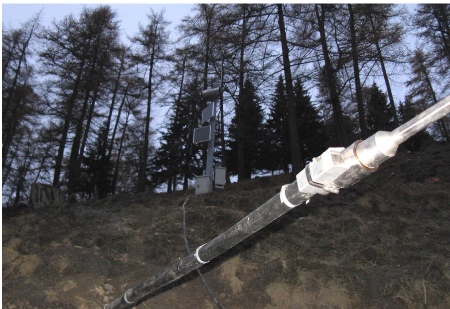
Figure 9 : Station de détection d'un système d'alarme avalanche (Liddes, Valais – Suisse, 1720 m)
