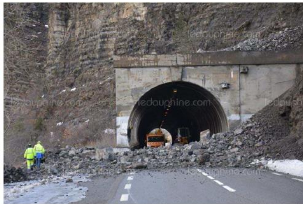
Un éboulement est survenu jeudi soir, à proximité du tunnel de Chaussetive, ce qui entraîne une coupure de la RD 900B dans les deux sens (Photo Le DL/Clément GASSY).
