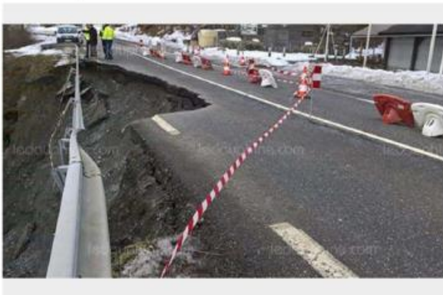
Les dégâts sont impressionnants, le long de la voie qui s'est effondrée au Sauze-du-Lac (Photo Bernadette FIGARELLA).
